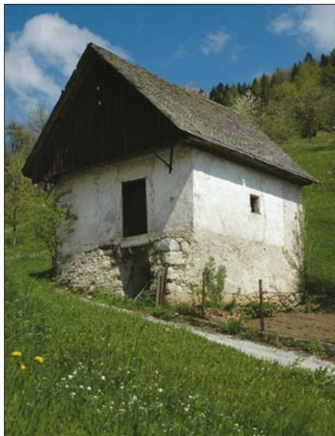
Po poteh stavbne dediščine
