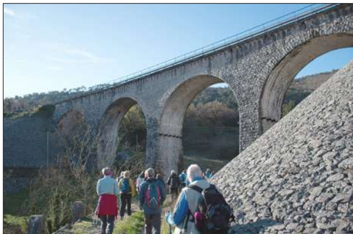
Železniški most nad Branikom (Foto: Julij Draskobler)
